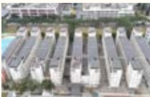
廠房與宿舍屋頂建置太陽能板
