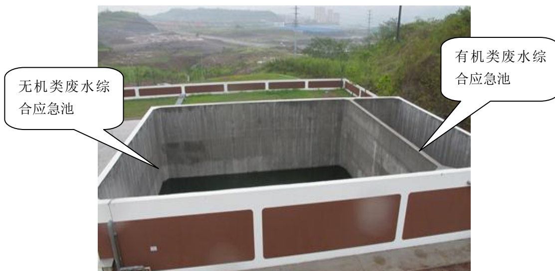
无机类和有机类废水综合应急池
