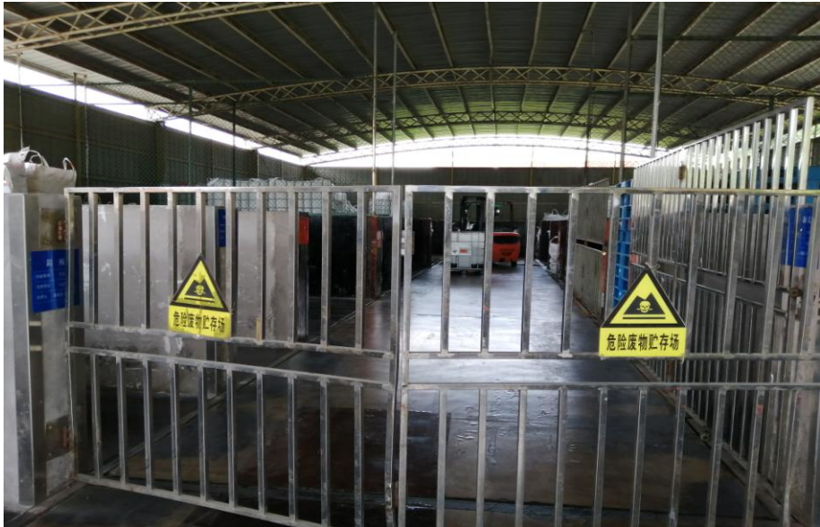
危险废物暂存间
