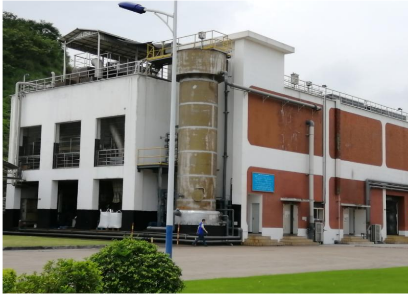
厂区废水处理站
