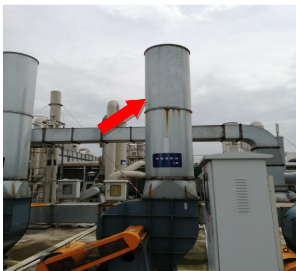
2-3#叠压热合、冷压排气筒
