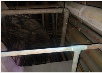
管道井改善前
